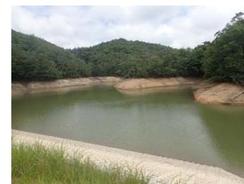
【例②】堤体等の安全性を確保するための水位低下と低水位管理
