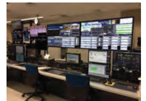
地域局番組送出設備
