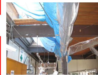
職業訓練棟の漏水対応状況
